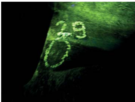
7.11. ábra Repedéshalmaz a járófelületen
